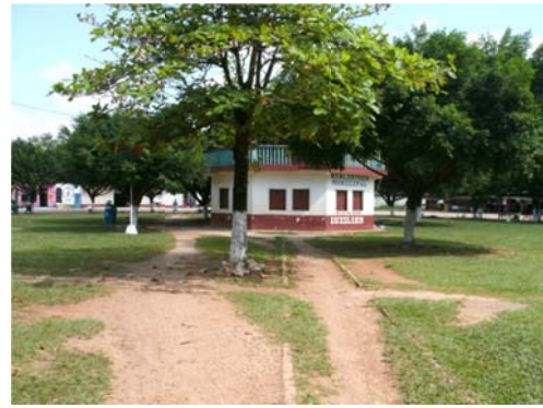
Foto 1. Antiguo edificio localizado en el parque central del municipio, que era destinado como alcaldía auxiliar
