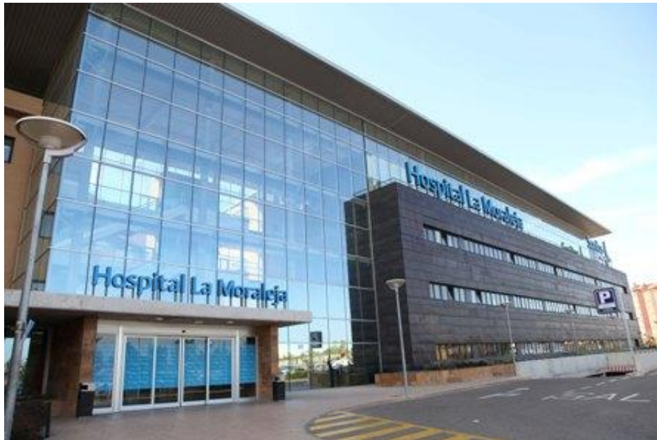
Fotografía 12 Fuente: Http://11870.Com/Pro/Hospital-Sanitas-La-Moraleja/Media , Fachada Principal Hospital Sanitas La Moraleja.
