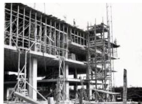
IMAGEN 54 fotografía digitalizada TEMA: AVANCE DE CONSTRUCCIÓN DEL CHN, 1963. FUENTE: archivo fotográfico del Crédito Hipotecario Nacional
