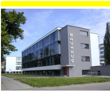
IMAGEN 8 Fotografía digital TEMA: EDIFICIO BAUHAUS / Dessau, Alemania. FUENTE: http://www.xtec.es/ On line, Enero 2013
