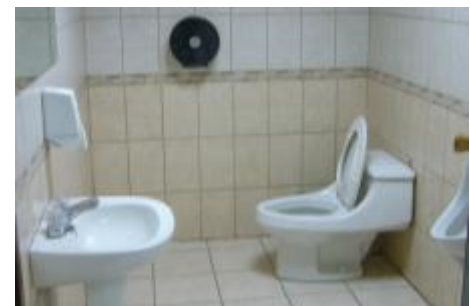
IMAGEN 74 fotografía digital TEMA: REMODELACIÓN DE S.S. EN INTERIOR DEL CHN. FUENTE: archivo fotográfico propio / 2012
