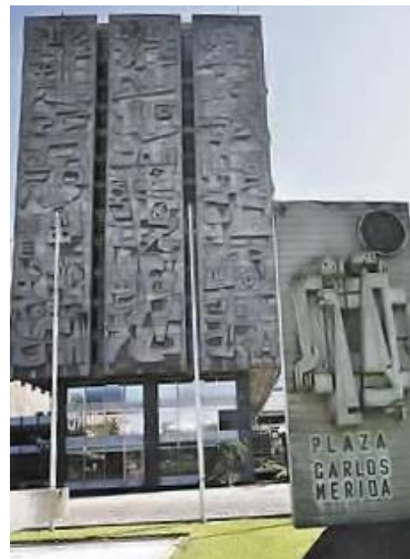
IMAGEN 28 fotografía digital. TEMA: PLAZA CARLOS MÉRIDA, EXTERIOR BANGUAT FUENTE: http://www.espaciopl.com.gt/ On line, Enero 2013
