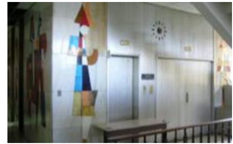
IMAGEN 71 fotografía digital TEMA: DETERIORO EN MURALES INTERIORES DEL CHN FUENTE: archivo fotográfico propio / 2012
