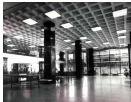
IMAGEN 56 fotografía digitalizada TEMA: LOBBY AL INGRESO DEL CHN, 1965 FUENTE: archivo fotográfico del Crédito Hipotecario Nacional
