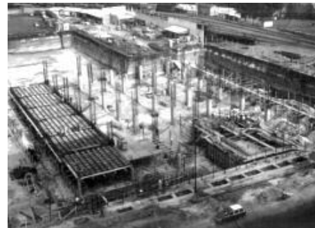
IMAGEN 53 fotografía digitalizada TEMA: INICIO DE CONSTRUCCIÓN DEL CHN, 1962. FUENTE: archivo fotográfico del Crédito Hipotecario Nacional
