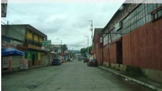
Imagen No. 33 – Pavimento de concreto.
