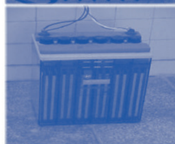
Fig. 2, 3 y 4. Ejemplos de panel solar, controlador y batería utilizados en Cuba en las instalaciones solares fotovoltaicas.
