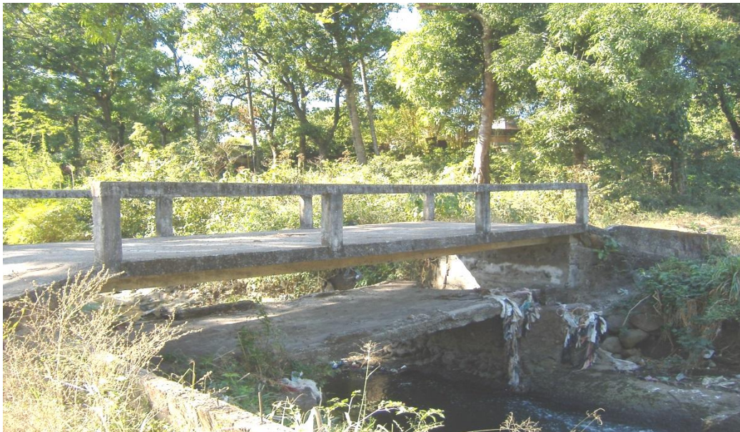
Puente de ingreso y egreso del proyecto
