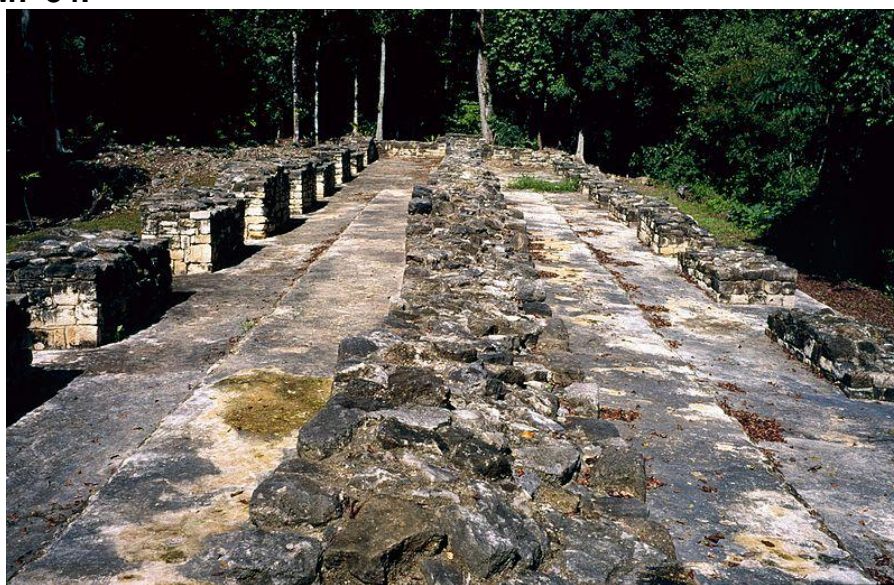
Fotografía 15: Fotografía de estado actual de edificio M7-26
