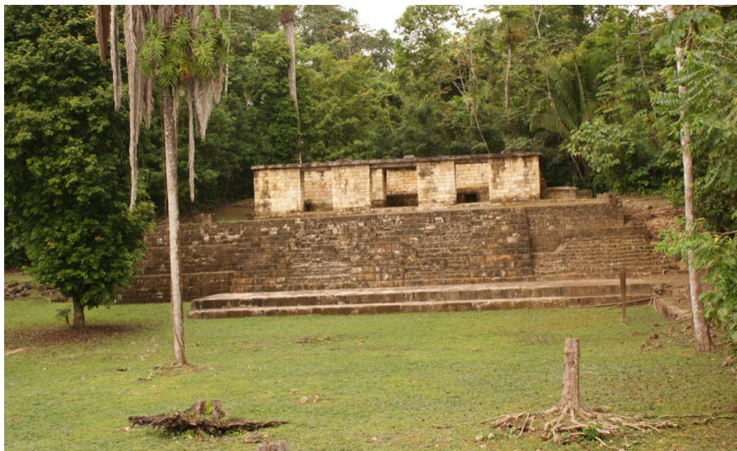
Fotografía 16: Fotografía de estado actual de edificio M7-32
