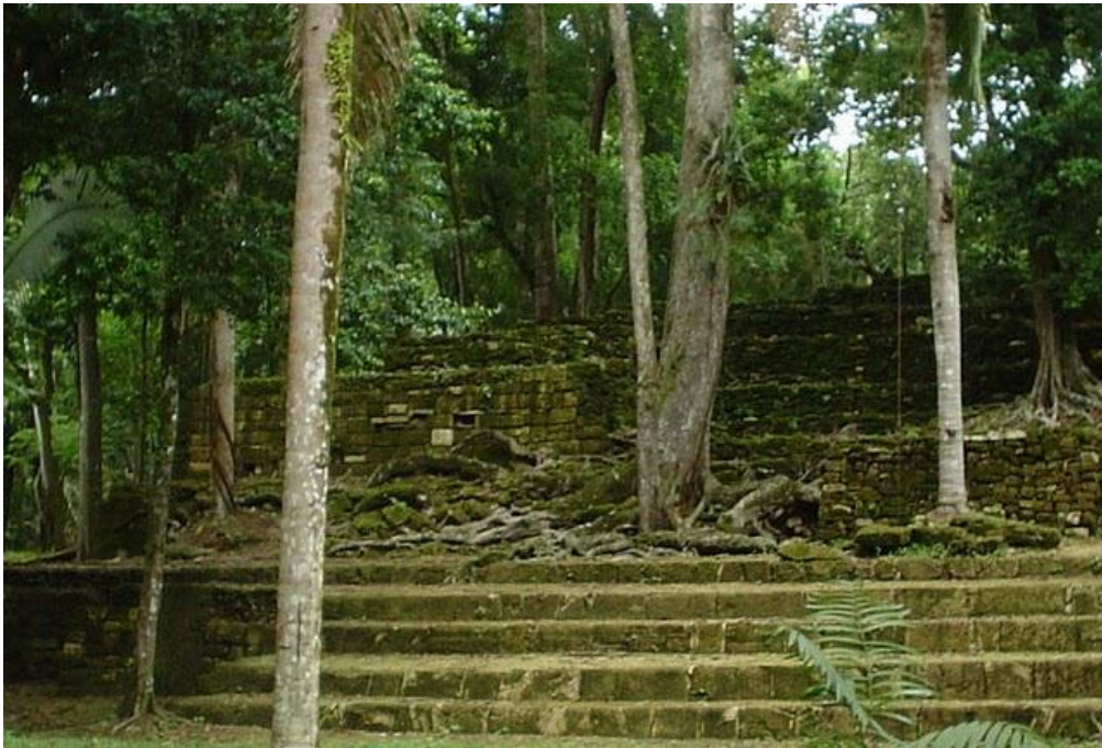
Fotografía 14: Fotografía de estado actual de edificio L8-8
