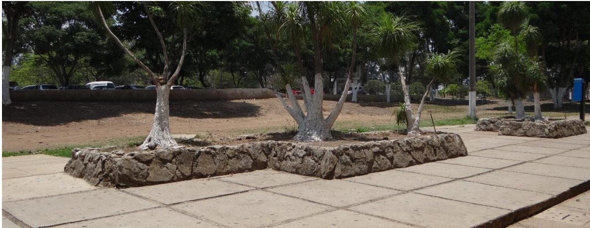
Muros bajos con fachaleta de piedra del diseño original
