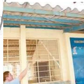
La cubierta de este establecimiento es de duralita con estructura metálica, el cual ha sufrido daños en algunas partes de su entorno
