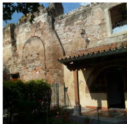
**Imagen 16.** Vista del ingreso a la Capilla de Adoración, donde se observa la cubierta de terraza española.
