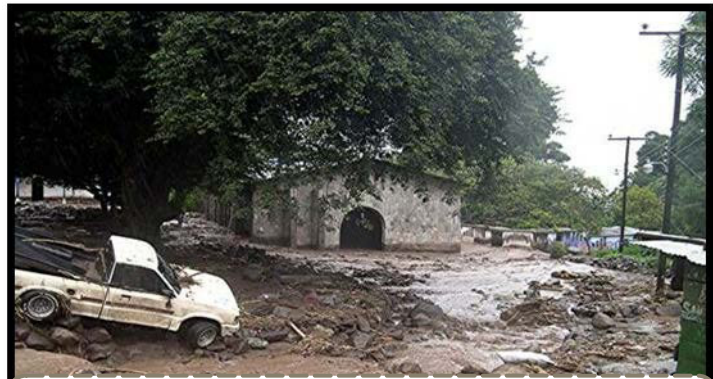
IMAGEN #1: Vivienda afectada por tormenta Stan año 2005, las Lagunas San Marcos. Fuente propia
