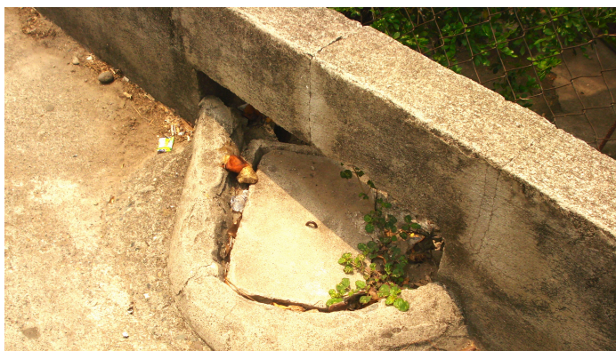
Las cajas de drenajes no cuentan con un lugar apropiado, se encuentran en el paso constante de vehículos y peatones.
