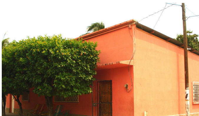
La mayoría de calles no cuentan con acera para circulación libre y sin riesgos de los peatones.
