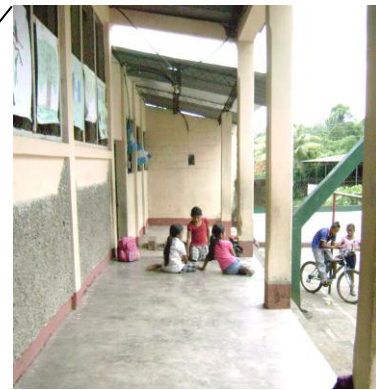
Corredor cuenta con piso de granito y tiene un ancho de 1.75m. Cuenta con cubierta de lámina y las instalaciones eléctricas se encuentra superficiales.
