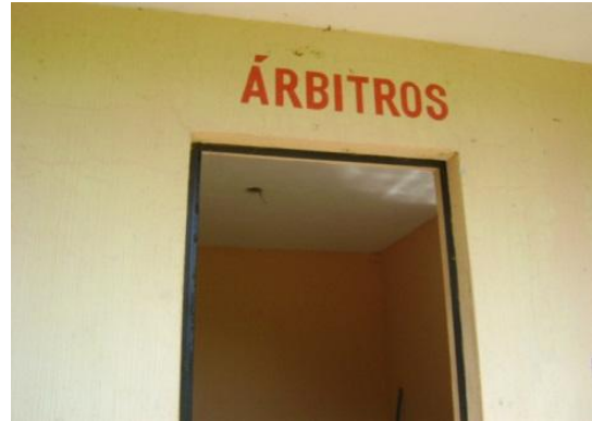
FOT. 43 Vista vestidores estadio municipal, La Libertad, Huehuetenango. Fuente: Elaboración propia
