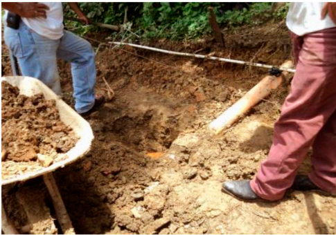
FOT. 45 Vista drenaje municipal en terreno de proyecto Fuente: Elaboración propia
