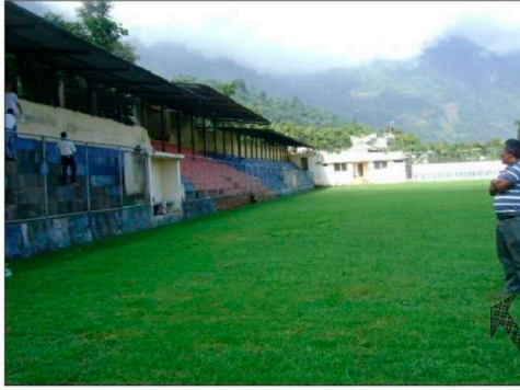
Se muestra el estadio actual en condiciones precarias, coincidiendo con el terreno para la propuesta del nuevo estadio municipal de La Libertad
