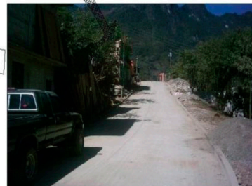
1A. AVENIDA Carretera principal asfaltada de doble via que va desde el parque central hacia el terreno, a un costado una calle peatonal sin ningun peligro de circulacion vehicular
