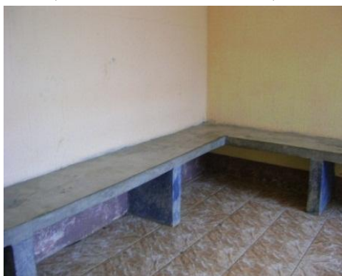
FOT. 41 Vista vestidores estadio municipal, La Libertad, Huehuetenango. Fuente: Elaboración propia
