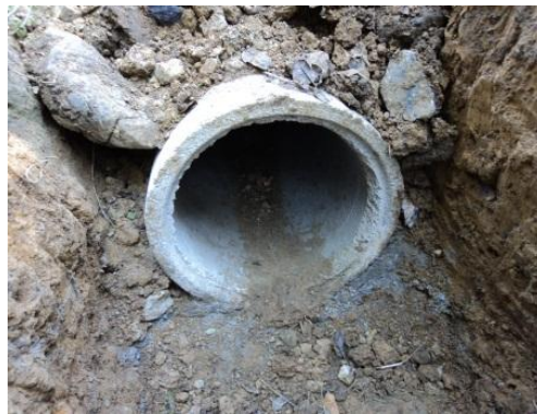
FOT. 32 Vista instalación drenaje, La Libertad, Huehuetenango. Fuente: Elaboración propia
