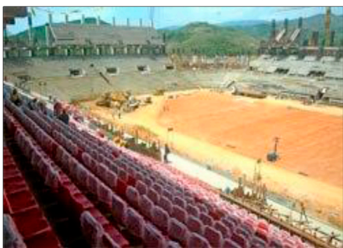
FOT. 9 Estadio en Construcción
