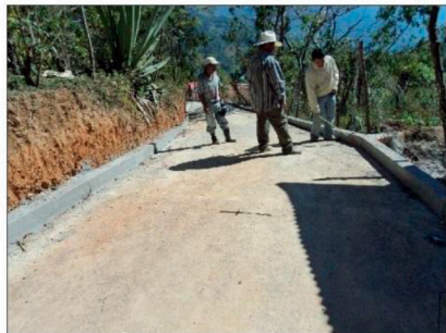
Calle aledaña al terreno, se puede apreciar es amplia para el acceso de vehículos, por lo que se puede considerar el ingreso al proyecto, libre de obstáculos.
