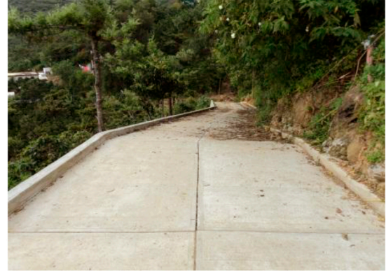
FOT. 44 Vista carretera a terreno de proyecto, La Libertad, Huehuetenango. Fuente: Elaboración propia
