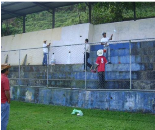
FOT. 35 Vista graderío del estadio municipal, La Libertad, Huehuetenango. Fuente: Elaboración propia
