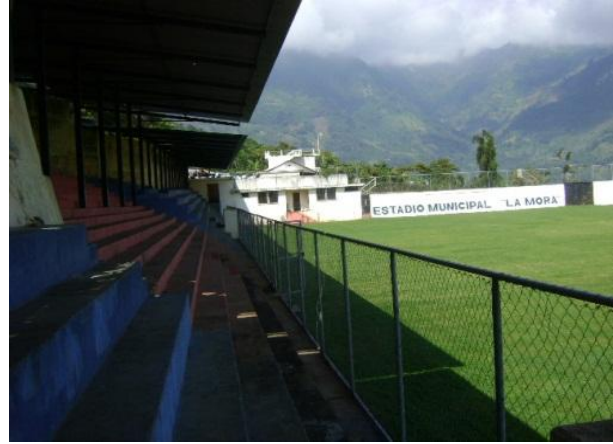
FOT. 34 Vista graderío del estadio municipal, La Libertad, Huehuetenango. Fuente: Elaboración propia
