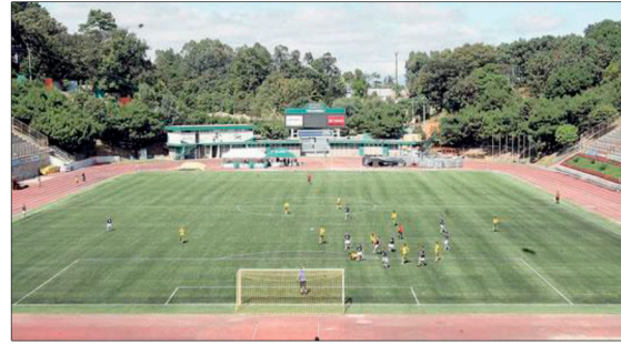
FOT. IO Estadio Cementos Progreso Fuente: www.lafutbolsoccer.com
