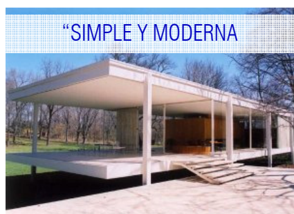
Fotografía 7 Casa Farnsworth, construida en 1,945 diseñada por Mies van der Rohe, para la doctora Edith Farnsworth
