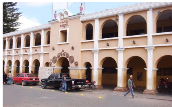
Fotografía 8: Municipalidad Tecpán, Chimaltenango. Fuente: DMP, Municipalidad Tecpán, 2013.
