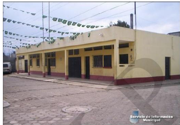
Fotografía 6: Edificio Antiguo (Demolido)
