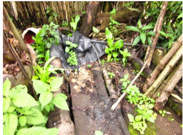
Figura 55. Fotografía de Pozo de absorción
