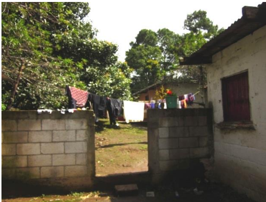
Figura 69. Fotografía de Medio muro, divide sectores.
