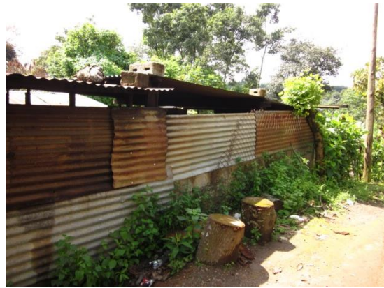
Figura 68. Fotografía de Vivienda. Cocina.
