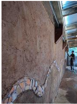
Figura 31. Repello del Muro de Block. Fuente: GERMINALIA A.C. (2011). Taller de Construcción Ecológica. Recuperado de: http://www.flickr.com/photos/ingeniogerminalia/sets/72157627174149657/detail/
