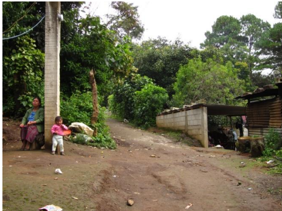
Figura 19. Fotografía de vía, área de viviendas y acometida eléctrica
