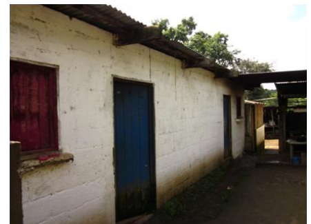
Figura 73. Fotografía exterior de dormitorios
