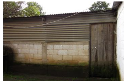
Figura 75. Fotografía de exterior de dormitorio
