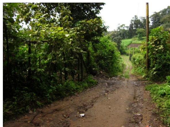
Figura 18. Fotografía de vía de terracería en la Zona de Amortiguamiento
