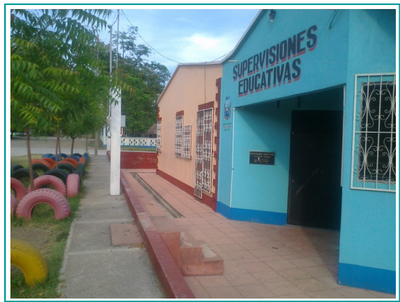
5. FACHADA LATERAL NOR OESTE
