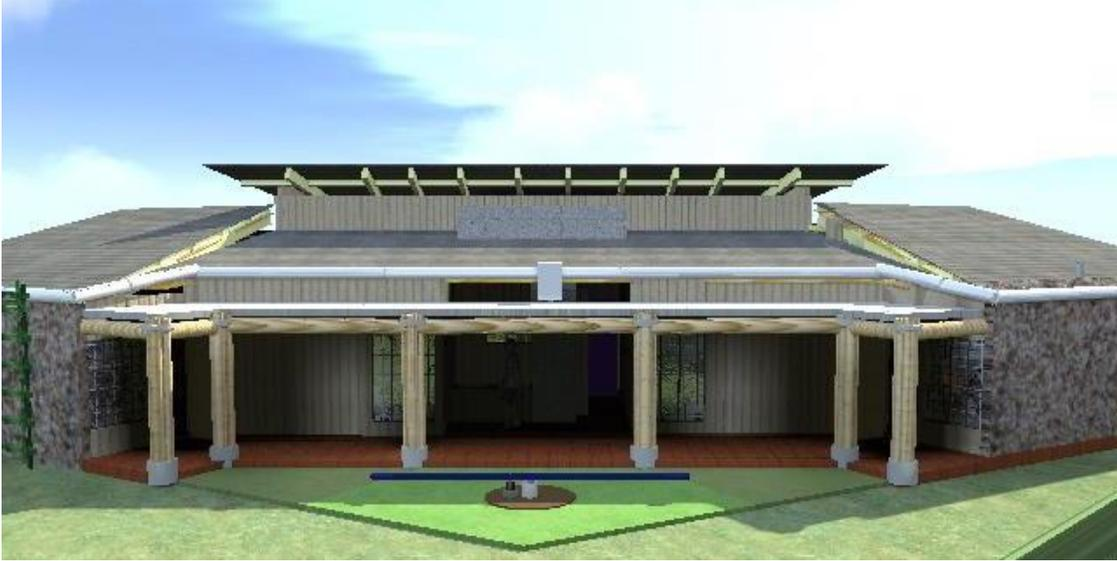
Se puede ver el corredor exterior de la vivienda que sirve para comunicación con el área de siembra y con el interior, además de la protección de los rayos del sol produciendo sombras.
