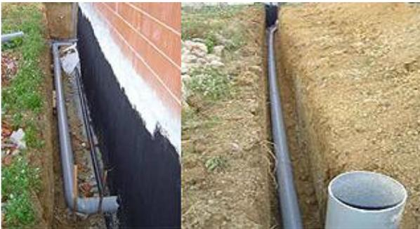
La tubería es colocada en el interior de la vivienda, provenientes del exterior en la zanja.
