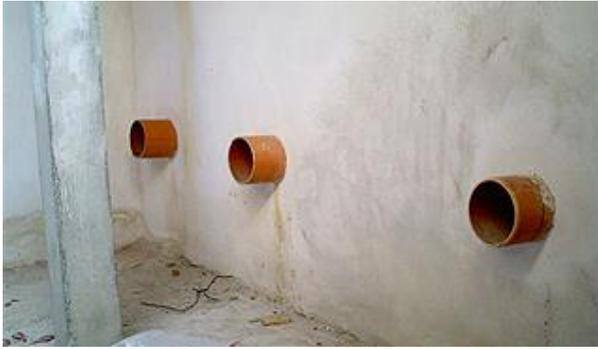
Las tuberías son colocadas en una zanja en el exterior, ya que estas varían su temperatura y se trasladan al interior de la vivienda por convección.
