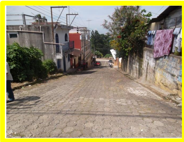
FOTO No.1 Este: Vía Secundaria
