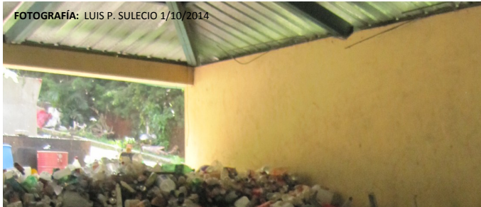
Fotografía No.3: Las piletas de degradado carecen de cubiertas protectoras contra la intemperie.
