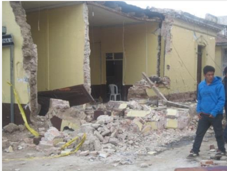
Fotografía.3 Terremoto 7 de Noviembre, San Marcos, Fuente Autor. Diciembre de 2013
