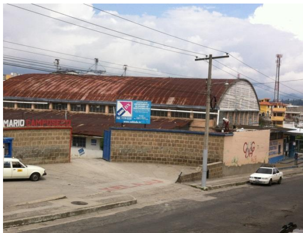
FOTOGRAFÍA NO. 8 VISTA GIMNASIO QUETZALTECO. (FUENTE: PROPIA)
