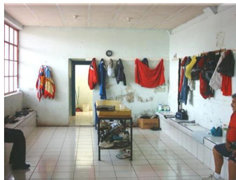
Foto 11. Vestuario Local Estadio M.C. Fuente: Tesis Estadio Quetzaltenango
