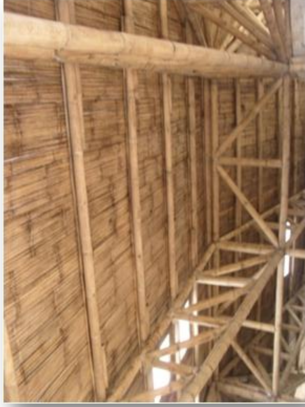
ESTRUCTURA PORTANTE DE BAMBÚ
