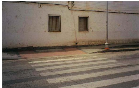
SECCIÓN DE VADO DE RESALTE CON BORDILLO ACHAFLANADO
