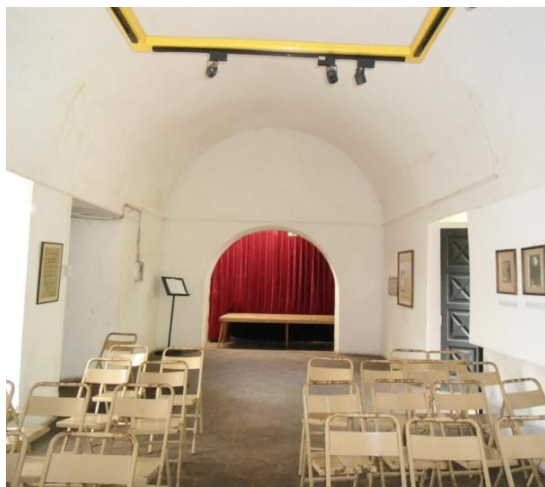
Fotografía 25: 5ta calle poniente, se observa el ingreso al Almacén de Pólvora, fachada frontal. Fotografía 26: Egreso del almacén ubicación norte. Fotografía 27: Interior del almacén ubicación Este. Fotografía 28: Interior del almacén ubicación Oeste. Se observa su ingreso y la bóveda de cañón corrido. Fotografía 29: Se observa la fachada lateral Este.
