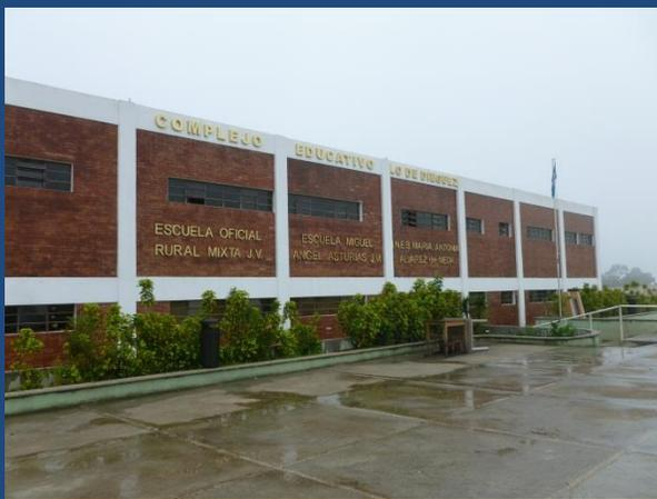
**Imagen 43:** La fachada principal del establecimiento tiene un acabado con fachaleta de ladrillo en los muros. El espacio frontal del edificio es utilizado como estacionamiento de vehículos.
