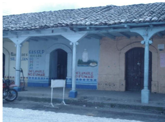
ILUSTRACIÓN 21 TIPOLOGIA DE VIVIENDA CON ADOBE Y MADERA FUENTE: INVESTIGACION DE CAMPO ELABORACIÓN PROPIA
