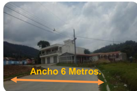
Fotografía No.63 Calle Pavimentada Ancho 6 Metros.
