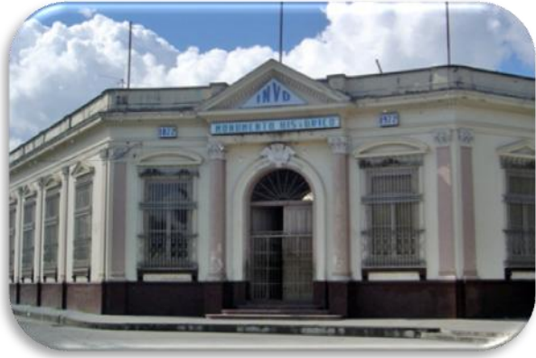
Fotografía No 11 Fachada Frontal Instituto Nacional Para Varones de Occidente./ Foto Archivo www.invoxela.com
