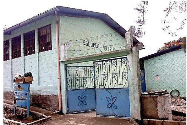
Fotografía No.21. Escuela Oficial Párvulos. Fuente: Fotografía Toma Propia
