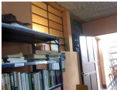
Fotografía No.1. Ventilación de los S.S. hacia el interior de la biblioteca.. Fuente: Fotografía Toma Propia
