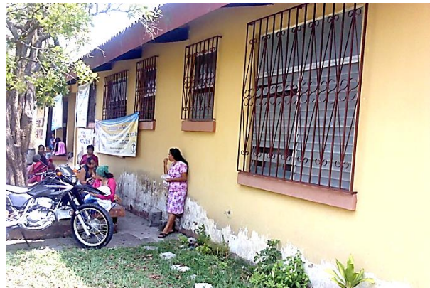
Fotografía No.18. Centro de Salud Tipo B. Fuente: Fotografía Toma Propia
