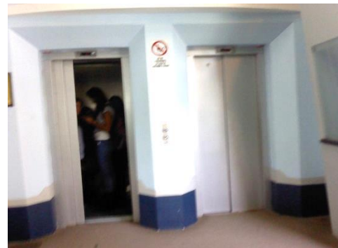
Fotografía No.75 Elevadores. Fuente: Fotografía Toma Propia
