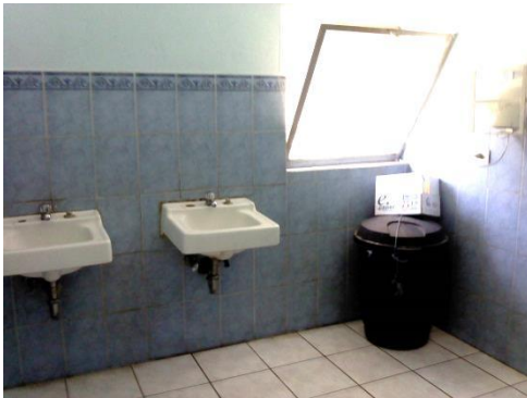
Fotografía No.52 Servicios Sanitarios. Fuente: Fotografía Toma Propia
