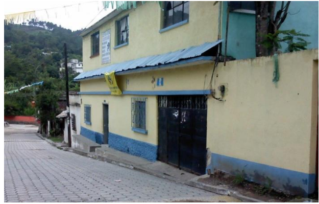
Fotografía No.29 Colegio Mixto. Fuente: Fotografía Toma Propia
