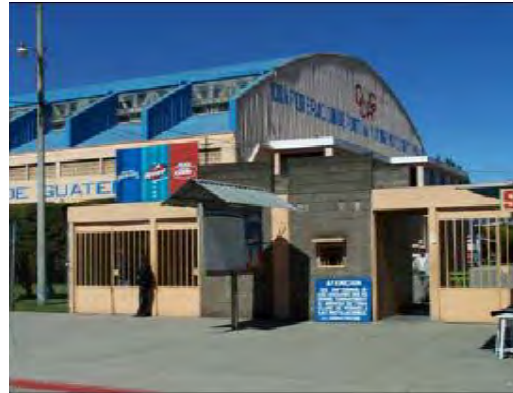
FOTOGRAFÍA: Ingreso a recinto deportivo desde el área de parqueo.
