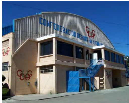
FOTOGRAFIA: Fachada de gimnasio polideportivo, el cual cuenta con un área de 2,183 metros cuadrados, en él se practica deportes como baloncesto, balonmano, voleibol, tiene un graderío con capacidad para 2,000 personas.
