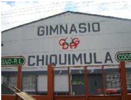
FOTOGRAFÍA 1.18.2 F- 18: VISTA DEL INGRESO PRINCIPAL AL GIMNASIO SOBRE LA 11 AVE. DE LA ZONA 1.
