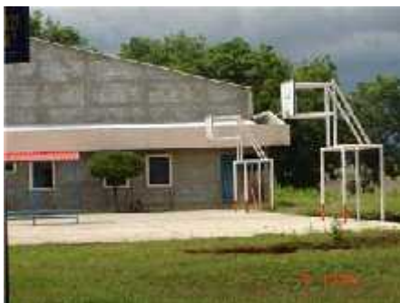
FOTOGRAFÍA 1.18.3 F- 21: IMAGEN DEL ÁREA DE CANCHAS DE BASQUETBOL Y FUTBOL, UBICADAS EN EL POLIDEPORTIVO.
