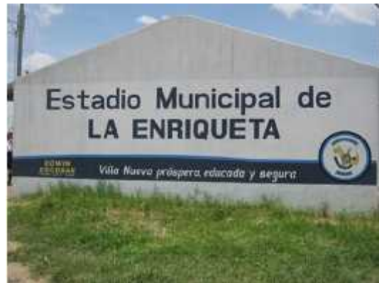
FOTOGRAFÍA III F- 2 ESTADIO MUNICIPAL: ENTRADA ESTADIO MUNICIPAL UBICADO EN TERRENO PROPUESTO PARA PROYECTO. FUENTE: PROPIA.
