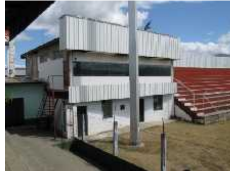
FOTOGRAFÍA 1.18.4 F- 23: IMAGEN DEL ÁREA DE VESTIDORES PARA EL EQUIPO LOCAL Y VISITANTE MÁS PARTE DEL GRADERÍO ORIENTE
