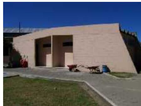
FOTOGRAFÍA 1.18.1.6 F- 17: MÓDULO DE BAÑOS Y VESTIDORES PARA MUJERES Y HOMBRES, TIPO DE ARQUITECTURA QUE DOMINA LA CONSTRUCCIÓN DE LAS INSTALACIONES.
