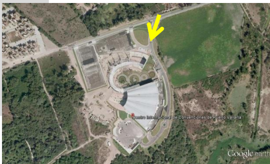
Imagen 71. Acceso Al Centro Internacional de Convenciones de Puerto Vallarta. Fuente: Google Earth
