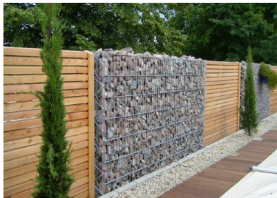
Imagen 102. Muro de Piedra. Tipo Gavión. Fuente: casasyfachadas.com
