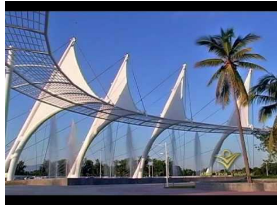
Imagen 76. Estructura Metálica en la Plaza Central del Centro de Convenciones de Puerto Vallarta: Fuente: www.cipuertovallarta.com
