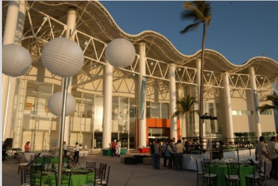
Imagen 74. Ingreso al Complejo Cancún Center. Fuente: www.cipuertovallarta.com
