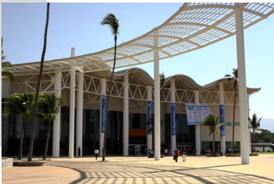
Imagen 75. Estructura Metálica en el Ingreso al Centro de Convenciones de Puerto Vallarta: Fuente: www.cipuertovallarta.com
