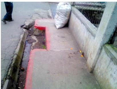
Candela municipal Y Agua Potable
