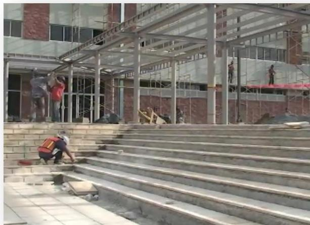
Para ingresar al edificio cuenta con un caminamiento techado utilizando columnas redondeas de metal y vigas de alma llena ancladas con pernos y platinas.
