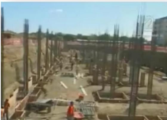
La fotografía muestra el proceso del sistema constructivo de marco estructural, se identifican las columnas principales que parten de sótano.
