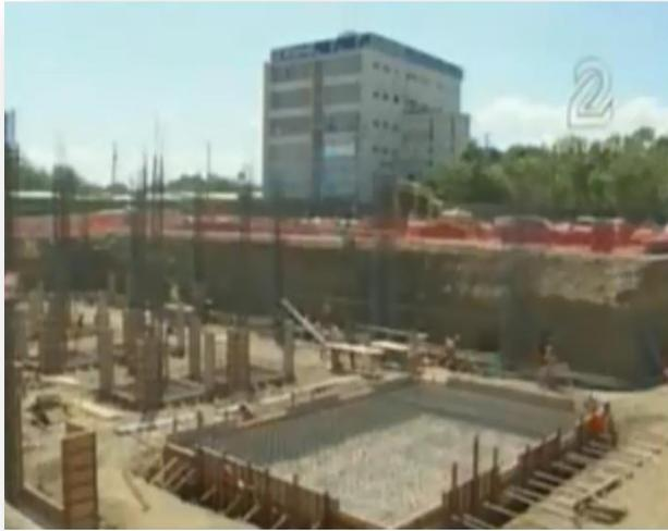
La fotografía muestra la ubicación de la losa de cimentación donde irán instalados los ascensores que comunicarán al edificio con sus diferentes niveles.
