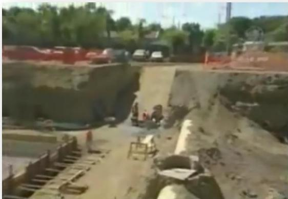
La fotografía muestra el corte de tierra realizado en donde irá ubicado el sótano del edificio.
