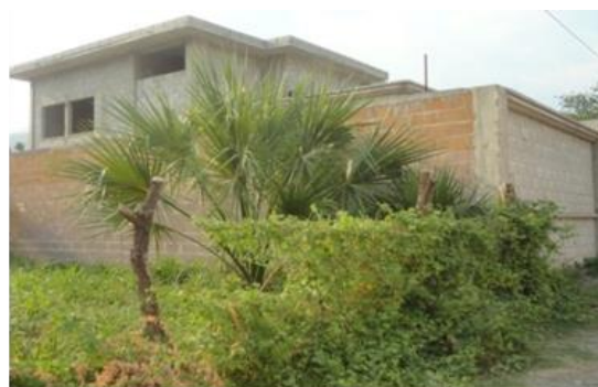
FOTO: 21 - SISTEMA CONSTRUCTIVO: 4 % - Vivienda de Ladrillo FUENTE: Cotóm, C. – Abril 2013
