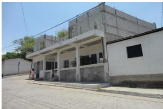
FOTO: 17 - SISTEMA CONSTRUCTIVO: 45 % - Vivienda de Block FUENTE: Cotóm, C. – Abril 2013
