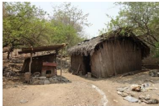
FOTO: 22 - SISTEMA CONSTRUCTIVO: 2% - Vivienda de Bambú FUENTE: Cotóm, C. – Abril 2013
