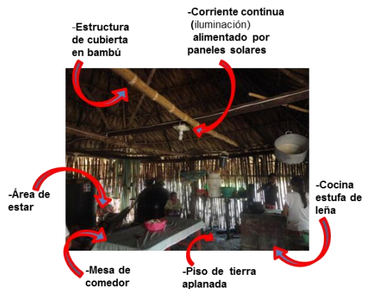
Vivienda Sostenible- Aldea las Maduras Puerto de Champerico - Retalhuleu. FUENTE: Cotóm, C. - Abril 2013 FOTO: 34
