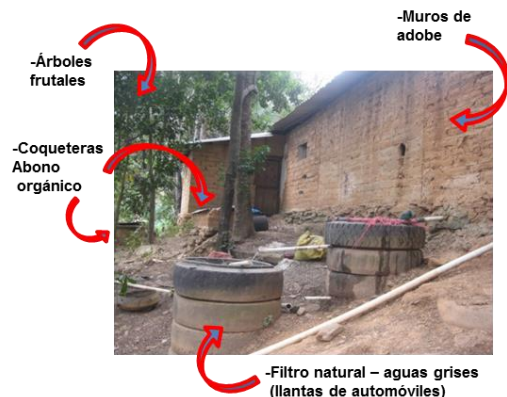
Vivienda Sostenible: Aldea Chanrayo San Agustín Acasaguastlán. FUENTE: Cotóm, C. – Junio 2013 FOTO: 40
