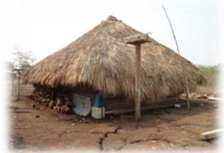
INFORMACIÓN DE CAMPO: Tipo de vivienda de la Comunidad con energía solar. FOTO 1 : Cotóm, C.
