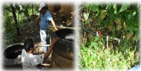
INFORMACIÓN DE CAMPO: Utilización de llantas + componentes naturales para formar filtro/sistema de riego por goteo. Vivienda Sostenible/caserío el Conacaste/ Chanrrayo/Sn Agustín Acasaguastlán/El Progreso. FOTO 7: Cotóm, C.
