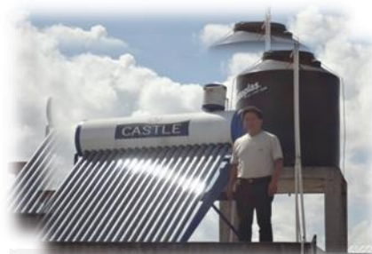
INFORMACIÓN DE CAMPO: Calentador solar y depósito de agua. FOTO 4: Cotóm, C.
