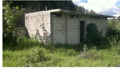
FOTO 3: EDIFICACION DE BLOCK ABANDONADA QUE CUMPLIA LA FUNCION DE GUARDIANA LA CUAL SE DEMOLERA PARA EL DESARROLLO DEL PROYECTO.
