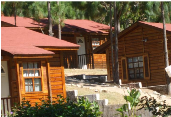
FOTOGRAFIA No. 3. AREA DE CABAÑAS Fuente: http://www.campamentodivinapromesa.com/cabanas.html
