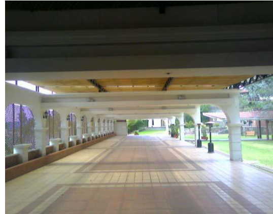
FOTOGRAFIA No. 14. PASILLO
