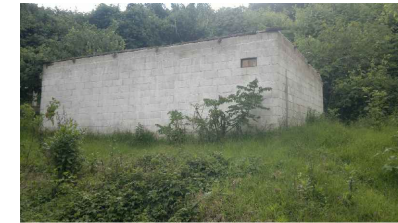
FOTO 6: VISTA POSTERIOR DE ANTIGUO GALLINERO EL CUAL FUE CONSTRUIDO DE BLOCK PERO DEBIDO A NUEVO PROYECTO SE PROCEDERA A DEMOLERLO
