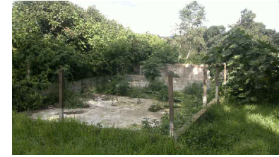
FOTO 5: EDIFICACION QUE CUMPLIA LA FUNCION DE GALLINERO DENTRO DEL TERRENO LA CUAL SERA DEMOLIDA PARA EL DESARROLLO DEL PROYECTO
