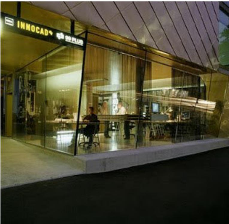
Este curioso edificio posee una estructura de hormigón con dos paredes ignífugas, dos pilares centrales y un pavimento de bloques de hormigón. La silueta del edificio es semejante a la de las construcciones colindantes con un último piso abuhardillado. La fachada dorada, realizada en cobre corresponde con los colores de INNOCAD, fue una tarea ardua convencer a los expertos de que el color dorado era el más idóneo para complementar a los edificios colindantes.
