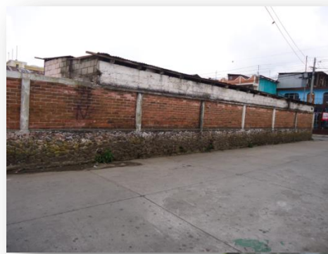
FOTOGRAFÍA SALÓN DE USOS MÚLTIPLES IMAGEN. ROCAEL BARRIOS AÑO 2011
