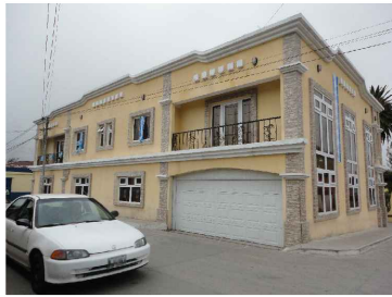
Fotografía 5: Municipalidad Fuente: Rocael Barrios visita de campo Paredes de Block, 2 niveles y losa de concreto.
