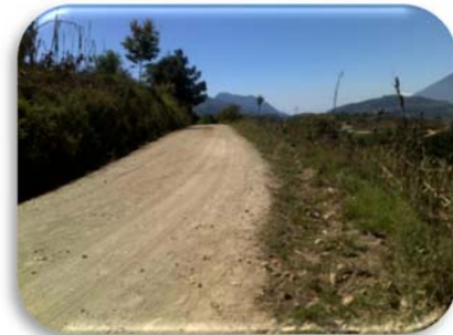
Imagen No.9 Camino de terracería Tecpán Fuente: www.tecpandegaleana.gob.mx
