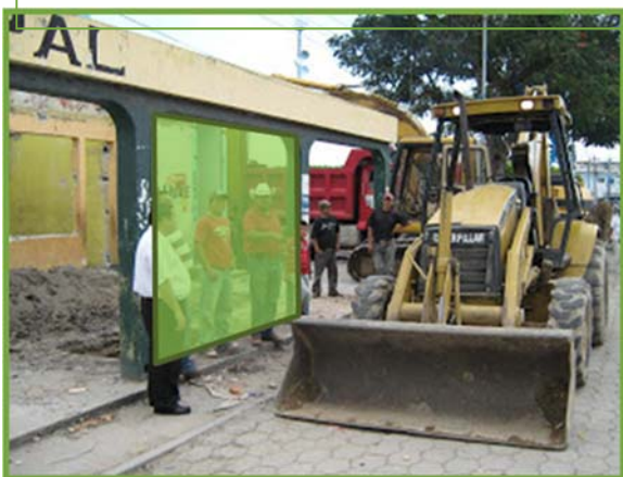
Fotografía: andie-wwwandie.blogspot.com/2011/06/construccion-mercado-municipal-de.html Fecha de Consulta Abril 2013
