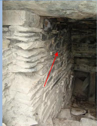
Muro Norte del interior de la cámara, puede verse el muro construido a plomo y con las paredes ahumadas formándose una pátina negra.
