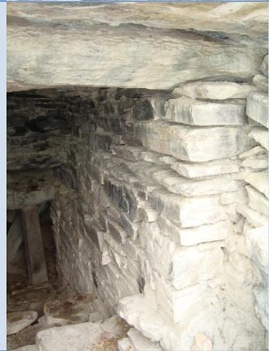
Techo de la cámara, el cual ya se encuentra bastante erosionado y ahumado, sin embargo, se observa estable estructuralmente.
