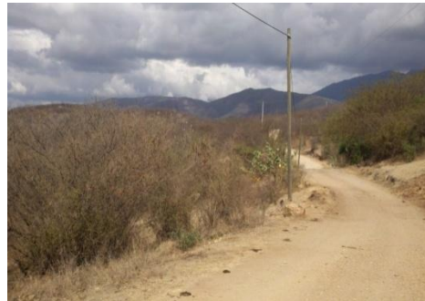
Foto 2: Se puede apreciar el estado actual de la carretera de acceso principal al terreno el cual es de terracería. Junio 2012
