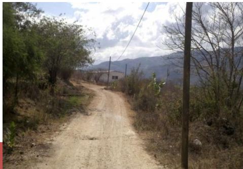
Foto 3: Se puede apreciar la infraestructura existente la cual consta únicamente de energía eléctrica y drenajes únicamente en una parte del tramo de carretera. Junio 2012
