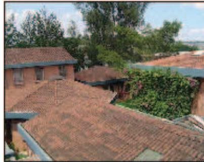
los materiales utilizados en fachadas y techos son tradicionales en el caso del techo se utiliza teja de barro cocido, así como para las fachadas se utiliza fachaleta de barro cocido, no tiene relación con el entorno ya que solo existen edificios de vivienda construidos con block.
