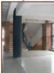
LA MODULACIÓN DE LA ESTRUCTURA NO COINCIDE CON LA FORMA ESTO GENERA PROBLEMAS COMO COLUMNAS EN ÁREAS DE CIRCULACIÓN EN ESTE CASO EN LOS PASILLOS
