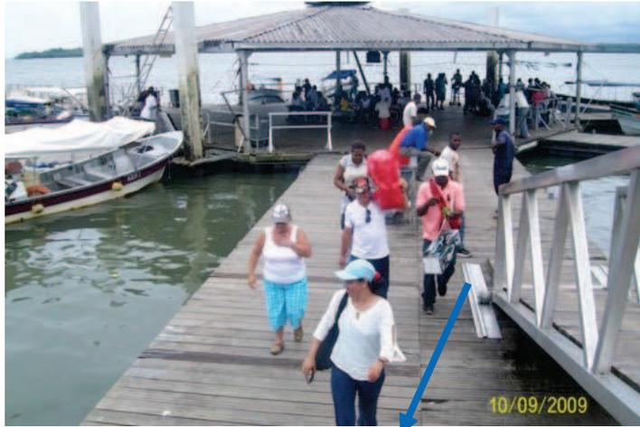
Rampa para muelle flotante Metálica. No necesariamente en todo el ancho del muelle.
