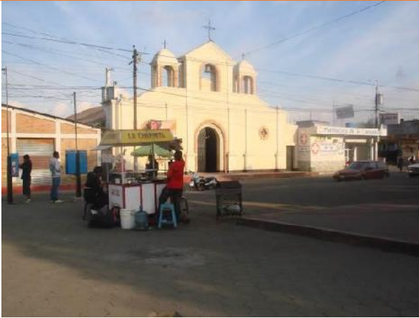
Ilustración 56: Vista a la iglesia Católica, del municipio de la Esperanza 185 .
