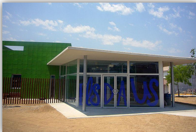
FOTOGRAFÍA No. 4 – Ingreso principal a Guardería “Els Daus”. Fuente y Elaboración: AIA Salazar-Navarro
