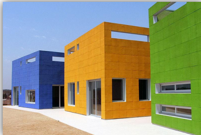
FOTOGRAFÍA No. 6 – Vista exterior de salones de niños. Fuente y Elaboración: AIA Salazar-Navarro
