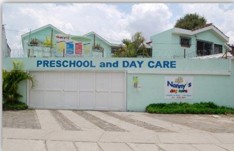
FOTOGRAFÍA No. 10 - Ingreso principal del centro. Fuente: www.mynannypreschool.com
