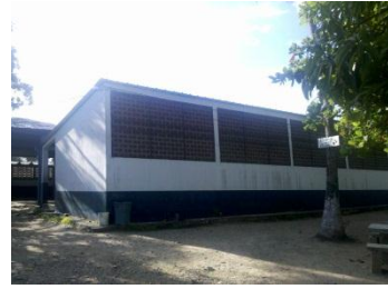
Foto No.49 Vista Aulas
