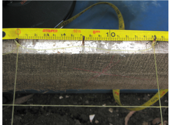
Trazo de muros sobre puente
