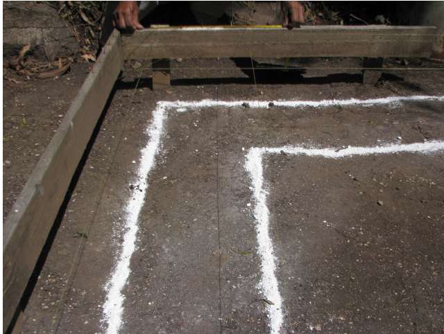
Trazo de ancho del cemento corrido
