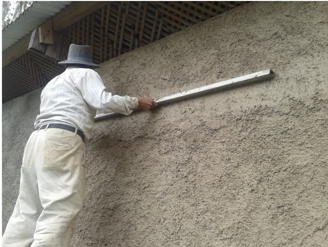
Nivelación del repello.
