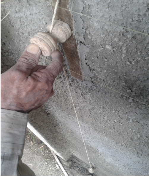
Chequeo con plomada, la colocación de la segunda maestra. (abajo.)
