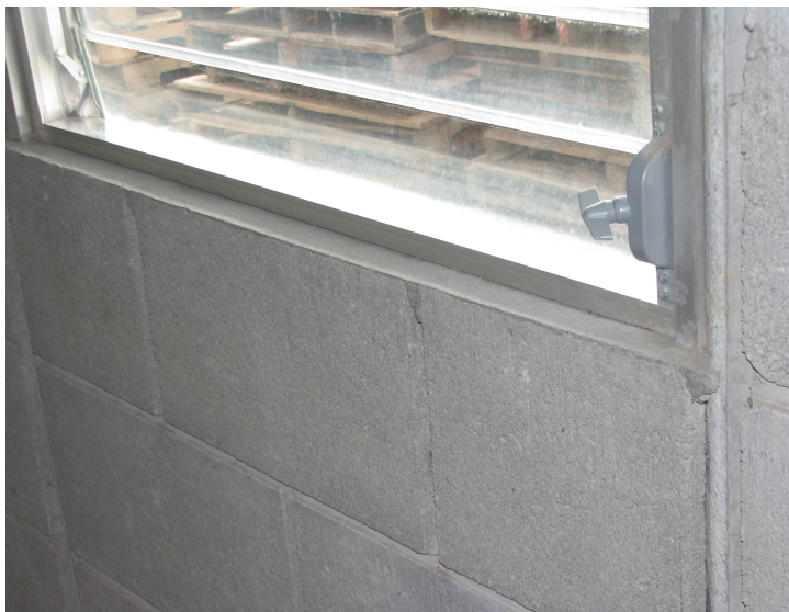
Detalle de sillar de ventana sin accesorio.
