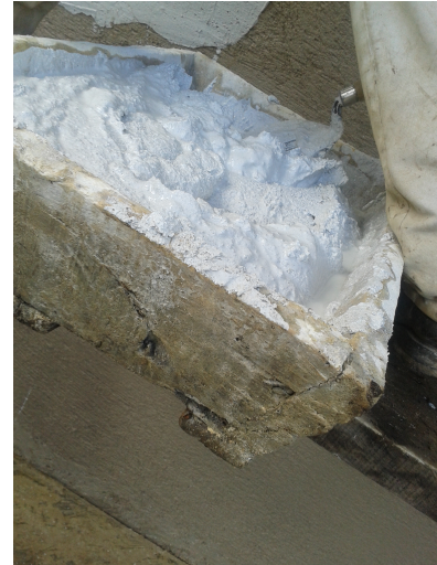
Colocación de mezcla en batea para su aplicación.
