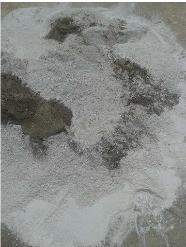
Mezclado de cal y arena blanca Cernida
