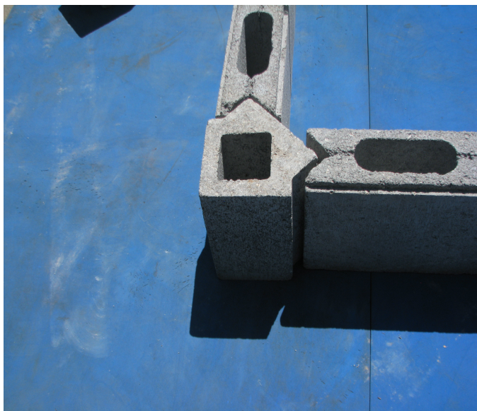
Detalle de accesorio tipo "L" en esquina
