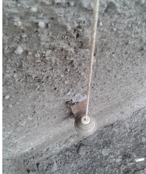
Plomada, confirmando colocación segunda maestra.
