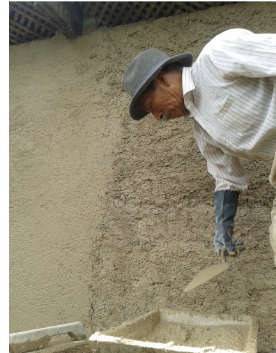
Llenado de la primera aplicacion de repello.
