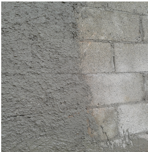
Ensabietado sobre bloques.
