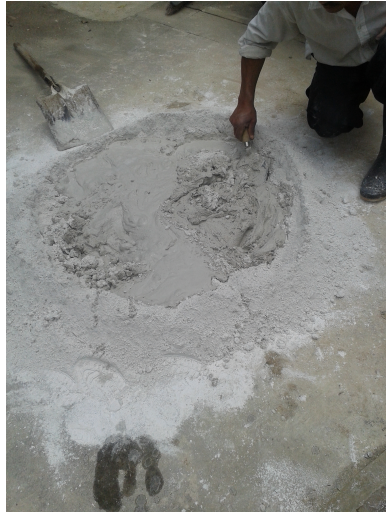
Mezclado de cal, arena cemento y agua.
