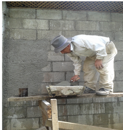
Muestra el andamio, cuchara y batea Para la aplicación de la sabieta.
