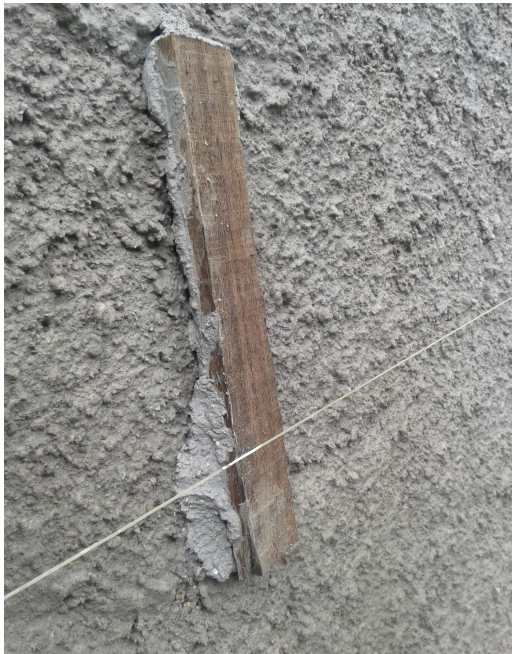
Colocación de maestras.
